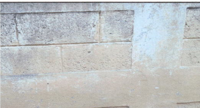
Foto 6: Pinturas en Muros Exteriores e Interiores
